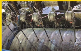
辊压机挤压辊在线修复
