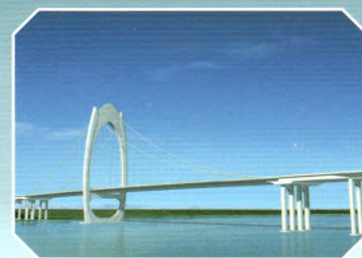
湘潭昭华湘江大桥
