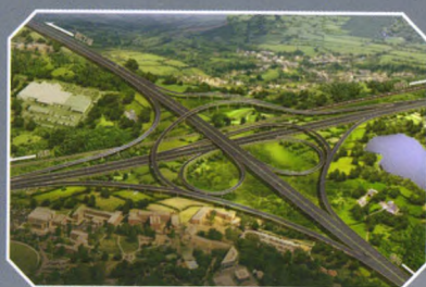
四川德都高速公路
