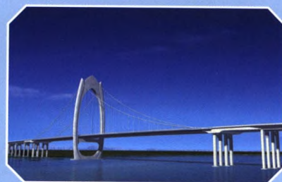
湘潭昭华湘江大桥
