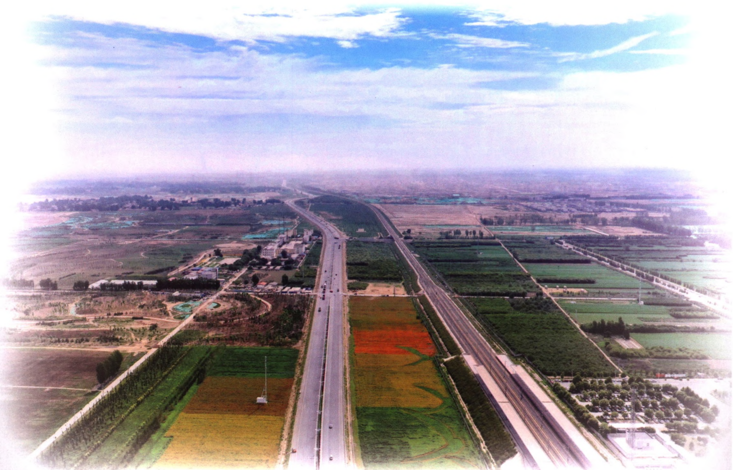
雄安新区容易线公路一期工程
