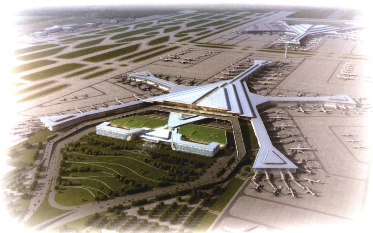
长沙机场改扩建工程
