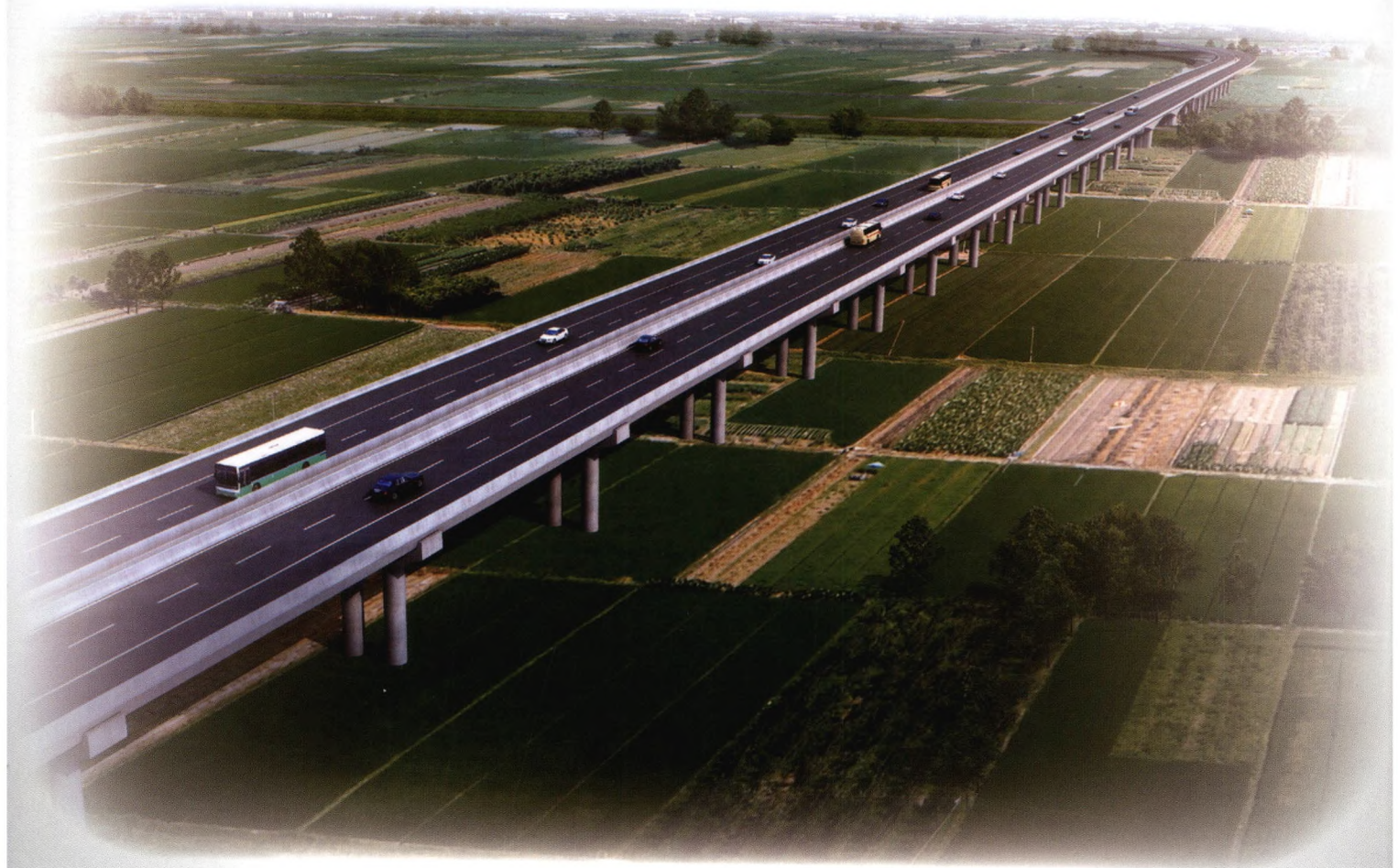
雄安新区雄县至白沟连接线（一期）工程
