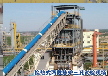
换热式两段焦炉三孔试验现场
