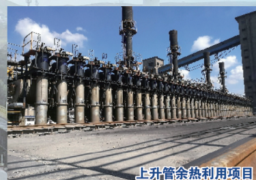
上升管余热利用项目
