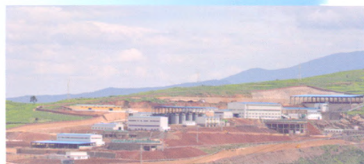
云南黄金集团北衙金矿采选工程
