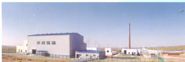
内蒙古长山壕金矿采选工程
