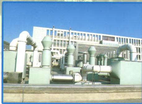
北京矿冶研究总院研发中心 实验室废气治理工程
