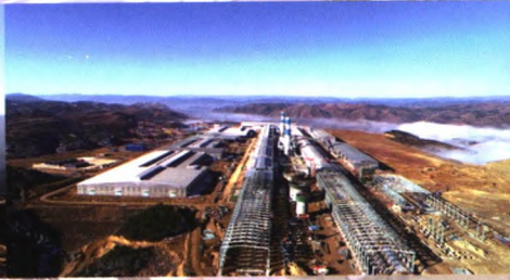
2019年1月项目现场全貌
