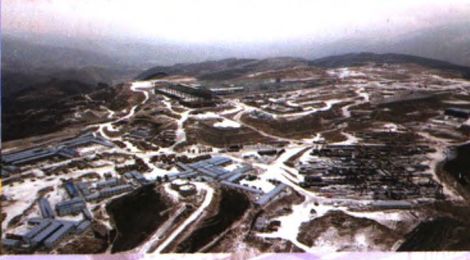
2018年1月项目现场全貌
