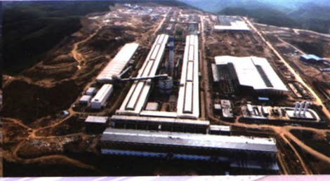
2018年5月项目现场全貌
