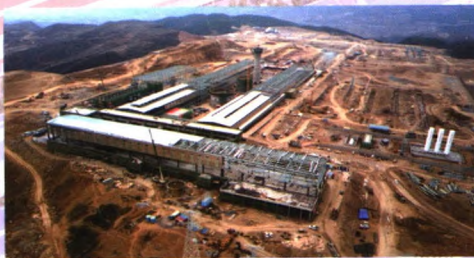
2018年3月项目现场全貌
