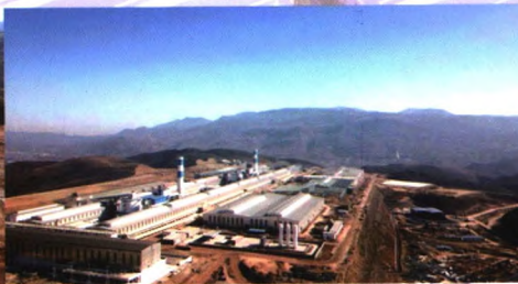
2018年10月项目现场全貌
