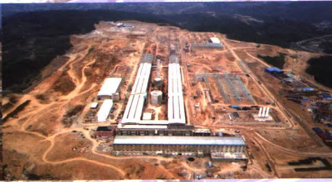
2018年4月项目现场全貌
