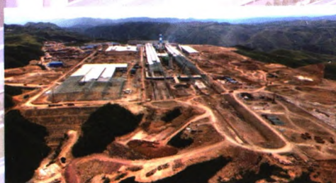
2018年7月项目现场全貌
