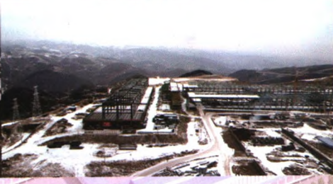
2018年2月项目现场全貌
