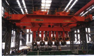
津西钢铁 150t 全自动轧辊更换起重机
