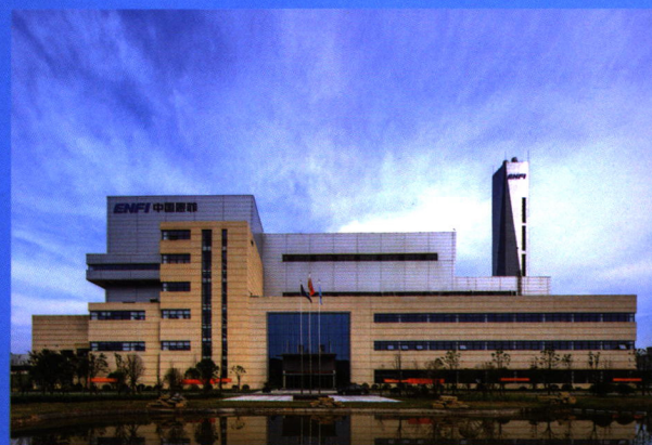
赣州市第二垃圾处理厂（焚烧发电厂）——BOT模式投资的环保项目，处理能力达 1200t/d，项目2019 年投产。
