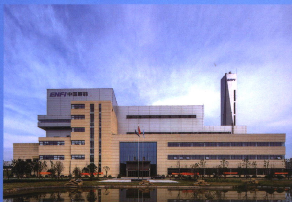
赣州市第二垃圾处理厂（焚烧发电厂）—BOT模式投资的环保项目，处理能力达 1200t/d，项目2019年投产。
