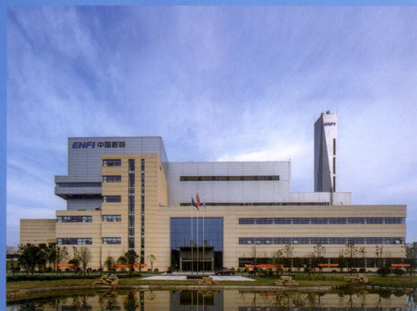
赣州市第二垃圾处理厂（焚烧发电厂）——BOT模式投资的环保项目，处理能力达 1200t/d，项目2019 年投产。
