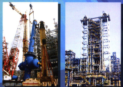
20万标立煤制 氢气化炉
