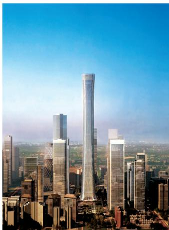
(封面图片为在建的北京第一高楼——中国尊大厦效果图，该项目于2013年7月开工，计划2018年9月竣工，位于北京市朝阳区CBD核心区，占地面积11478m<sup>2</sup>，总建筑面积约43.7万m<sup>2</sup>，其中，地上建筑面积35万m<sup>2</sup>，地下面积8.7万m<sup>2</sup>。高度528m，地上108层，地下7层，基础埋深38.2m。该工程集办公、观光、多功能中心等功能于一体，建成后将成为全球首座在抗震设防烈度8度地区的超500m的建筑。中建精诚工程咨询有限公司受业主委托，为该项目提供招标代理和全过程造价咨询服务。)
