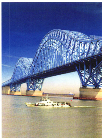
(封面图片为京沪高铁南京大胜关长江大桥,是世界首座六线铁路大桥,为世界上设计荷载最大的高速铁路大桥,代表了当前我国桥梁建造的最高水平。图片为中铁物总国际招标有限公司提供。)
