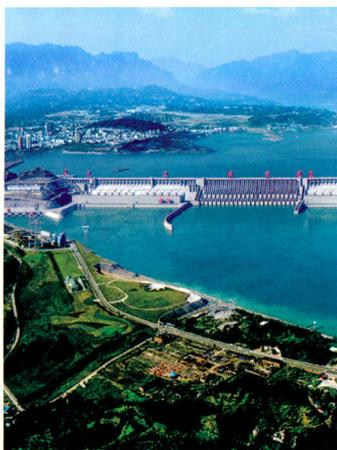
(封面图片为三峡水电站,即长江三峡水利枢纽工程,是世界上规模最大的水电站,也是我国有史以来建设最大型的工程项目。三峡水电站大坝高程185米,蓄水高程175米,水库长2335米,总投资954.6亿元人民币,安装32台单机容量为70万千瓦的水电机组。图片为三峡集团黄正平拍摄,三峡国际招标有限责任公司推荐。)
