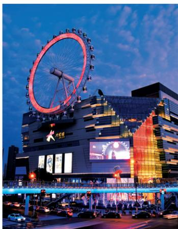
封面图片：随着上海大悦城的开业，国内首个屋顶悬臂式摩天轮SkyRing(天空指环)已于2016年2月初开放。该摩天轮为悬臂式摩天轮，全轮辐钢索结构，直径56m，距离地面106m，拥有30个轿舱，每个轿舱可载客6人。上海大悦城将SkyRing称之为国内首个悬臂式屋顶摩天轮。对此，有网友质疑称：“首个”的说法有误，长沙、广东中山以及苏州，都有屋顶摩天轮，并不稀奇。对此，上海大悦城表示，SkyRing强调的是屋顶悬臂式，网友说到的其他几个屋顶摩天轮，大多机构传统，身型笨重。而SkyRing采用拉索式，结构较其他几个都轻盈得多，与著名的“伦敦眼”结构一样，最大限度地减轻对建筑的压力，保障安全，在国内确实首创。上海东方投资监理有限公司为该项目提供招标代理和全过程投资监理服务。上海东方投资监理有限公司党委副书记、工会主席王鸣跃摄影并撰文。
