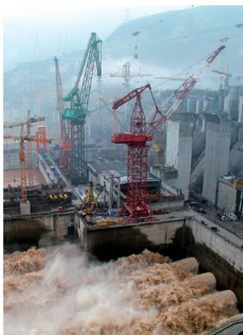
封面图片：《中流砥柱》照片中所展示的为金沙江上游洪水以每秒1.68万m<sup>3</sup>的流量通过向家坝水电站左岸导流底孔，流向下游的情形。拥有高大“身材”的向家坝电站大坝能够抵挡金沙江百年一遇的洪水，有效地降低了金沙江流域的洪水灾害。向家坝水电站安装了世界上单机额定容量最大的混流式水轮发电机组，单机额定容量为80万kw，总装机容量640万kw，总投资约542亿元，是我国仅次于三峡电站和溪洛渡电站的第三大水电站，也是世界第六大水电站。向家坝电站除了为国家提供源源不断的巨量清洁能源外，还有极好的防洪作用。向家坝电站的设计渡汛标准为每秒3.2万m<sup>3</sup>，正常蓄水位380米，水库面积95.6km<sup>2</sup>，控制流域面积45.88万km<sup>2</sup>，占金沙江流域面积的97%。水库总库容51.63亿m<sup>3</sup>，防洪作用十分明显。（中国三峡集团公司李毅军摄影并撰文）
