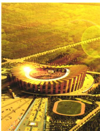
封面图片：鄂尔多斯市体育中心游泳馆是内蒙古自治区“十二五”重点规划项目，“鲁班奖”工程，总建筑面积48166.8m<sup>2</sup>，其主体设计大胆采用了倾斜支柱方案，主体由四条不同圆心不同弧度的曲线构成，36根混凝土柱将建筑围合并承托起外围护体系，穹顶直径长达128m。主体结构类型为钢筋混凝土框架结构，檐口最高点27m，巨型斜柱最高点标高36.7m。屋盖为大跨钢桁架结构，总重量约为3800t。混凝土斜筒体支撑体系复杂，共设置了55个混凝土剪力墙筒，内部为劲钢混凝土组合结构，筒体与地面呈75°向圆心外侧倾斜。游泳馆主体地上三层、地下一层，设国际标准游泳比赛池、国际标准跳水池、放松池、热身池及戏水乐园，看台座席共4042座，工程由河北建设集团有限公司承建，于2014年9月19日竣工并交付使用。
