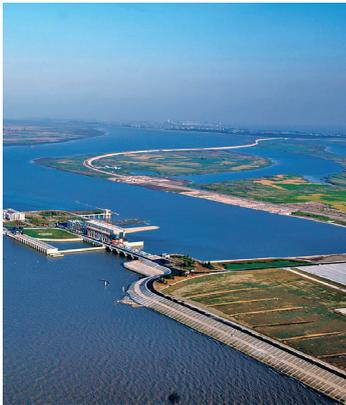
封面图片：上海青草沙水源地原水工程。该工程是创建国家环保城市的重要项目，是改变上海取水、供水格局，提供优质水源，造福上海老百姓的民生工程，荣获第十三届中国土木工程詹天佑奖。该项目由水库及取水泵闸、长江原水过江管、陆域输水管线及增压泵站三大主体工程组成，总投资约170亿元，于2006年开工建设，2011年6月8日正式建成投运。建成后，水库总面积约67.2km<sup>2</sup>，最大有效库容达5.53亿m<sup>3</sup>，设计有效库容为4.35亿m<sup>3</sup>。设计供水规模719万m<sup>3</sup>/d，供水范围覆盖杨浦、虹口、闸北、黄浦、静安、长宁、普陀、徐汇等8个区，受益人口达1150万人。
