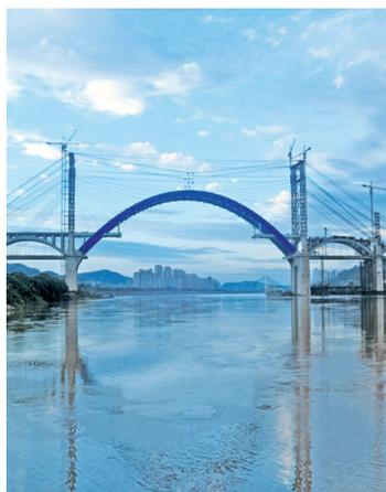
封面图片：宜宾金沙江公铁两用桥是建设中的成贵铁路跨越金沙江的重要通道，是全线关键控制性工程之一，全长1874.9m。建成后的大桥将创造多项国际和国内建桥纪录：主跨336m为世界最大跨度的公铁两用钢箱拱桥；铁路桥面在上，为四线高速铁路，公路桥面在下，为六车道城市快速主干道，公铁两用拱桥布置系国际首例；铁路桥面距公路桥面高差达到32m，在公铁两用桥梁中属世界第一；公路桥面柔性吊杆，穿过铁路桥面刚性吊杆的刚性吊杆结合的公铁两用钢箱拱桥，系国内首例。此桥于2014年1月1日开工建设，建设工期为48个月，预计2017年底完工。
