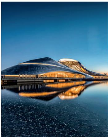
封面图片：哈尔滨大剧院是哈尔滨标志性建筑，依水而建，与哈尔滨文化岛的定位和设计相一致，体现北国风光大地景观的设计概念。为了满足消防、声学、美学等多方面要求，设计师创新性地采用了玻璃纤维增强水泥(GRC)作为基底材料，再在其表面上粘贴装饰木条。总计20多万根的水曲柳木条，总长度达到了190公里，全部由技术工人手工粘贴完成，再进行表面打磨和油漆施工，最终呈现出了实木般的纹理和色彩。大剧院的钢结构几乎涵盖了钢结构施工的所有类型和工艺，仅主材重量就达到了7000多吨，相当于一座埃菲尔铁塔。大剧院的金属屋面展开面积达到5万多平方米，相当于7个足球场的面积。哈尔滨大剧院工程获得“第十四届中国土木工程詹天佑奖”等奖项。
