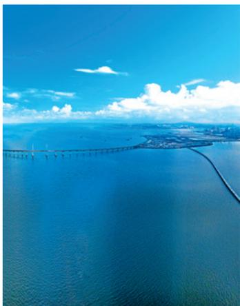
封面图片：港珠澳大桥总长55公里，是连接香港特别行政区、珠海和澳门特别行政区的超大型跨海通道，也是迄今世界最长的跨海大桥，被誉为世界桥梁建设史上的“王冠”，其中主体工程由6.7公里的海底沉管隧道和长达22.9公里的桥梁工程组成，隧道两端建有东、西两个人工岛。作为世界级的超级工程，港珠澳大桥实现了“六个最”：世界总体跨度最长、钢结构桥体最长、海底沉管隧道最长的跨海大桥，也是世界公路建设史上技术最复杂、施工难度最高、工程规模最庞大的桥梁。
