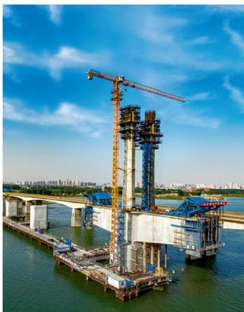
封面图片:蒙华铁路汉江特大桥位于湖北省襄阳市区上游约3公里的汉江上,总长5242米,是蒙华铁路重点控制性工程之一。该桥江面共18座桥墩,位于江面上的主桥为双塔五跨部分斜拉桥,最大跨径248米。
