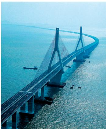
封面图片：东海大桥起始于上海市浦东新区芦潮港，北与沪芦高速公路相连，南跨杭州湾北部海域，直达浙江省嵊泗县小洋山岛，全长32.5公里。东海大桥是中国第一座真正意义上的外海跨海大桥，是上海国际航运中心深水港工程的重要组成部分，曾被上海市政府列为“一号工程”。大桥桥宽31.5米，分上、下行双幅桥面，双向6车道，设计时速每小时80公里。大桥全线按高速公路标准设计，设计基准期为100年。大桥的最大主通航孔离海面净高达40米，可满足万吨级货轮的通航要求。东海大桥不只是大桥在东海上海画出了一条完美的弧线，更大的意义是为以后的跨海大桥建设积累了丰富的经验。沪港国际咨询集团是东海大桥的建设者之一，为东海大桥提供了竣工财务审计服务，其出具的审计报告已存入历史档案，将永久留存。
