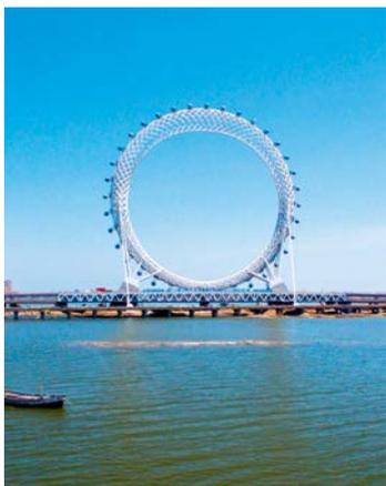
封面图片：白浪河大桥摩天轮坐落于潍坊市白浪河大桥中央，横跨了白浪河大桥，采用无轴式轮桥一体化设计，轮盘直径125m，总高度145m，比享誉世界的“伦敦眼”还高出10m，被业界公认为世界最大的无轴式摩天轮。这座摩天轮创下了三个世界之最：世界上最大的无轴式摩天轮、世界上首例编织网格形式摩天轮、世界上首次无轴式轮桥合一摩天轮。与常规的摩天轮中间有轴、刚性或柔性支撑绕轴转动不同，白浪河摩天轮的设计灵感来自风筝之都潍坊的风筝设计理念，中间没有任何支撑，运行时轮盘不转动，轿厢自带行走机构，通过轨道沿轮盘转动。因此，白浪河大桥摩天轮又被当地称为“未来之眼”、“渤海之眼”。
