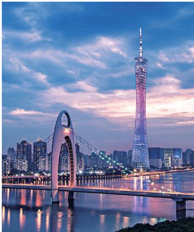
封面图片:广州塔建筑总高度600m,其中主塔体高450m,天线桅杆高150m,具有结构性超高、造型奇特、形体复杂、用钢量多的特点。它的外框筒由24根钢柱和46个钢椭圆环交叉构成,形成镂空、开放的独特美体,仿佛在三维空间中扭转变换。作为目前世界上建筑物腰身最细(最小处直径只有30多m),施工难度最大的建筑,建设者们克服了前所未有的工程建筑难度,把1万多个倾斜并且大小规格全部不相同的钢构件精确安装成挺拔高耸的建筑经典作品。
