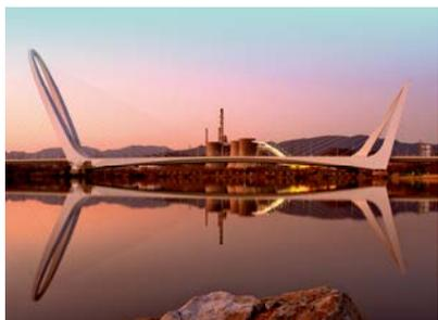
封面图片：新首钢大桥是北京市境内的一条连接石景山区和门头沟区的过江通道，横跨永定河，是长安街西延工程的关键节点。大桥全长1354米，宽54.9米，主路设4上4下8条车道，是北京市西部的地标性建筑和目前我国最宽的钢桥梁。
