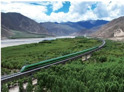
封面图片:拉林铁路是我国首条高原电气化铁路,连接西藏境内的拉萨市与林芝市,全长435.48公里,设计速度160公里/小时,是在建的川藏铁路的重要组成部分,也是规划中的滇藏铁路、甘藏铁路的共线路段。
