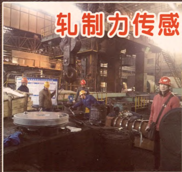
我公司在邯钢中板厂3500t压头安装现场指导
