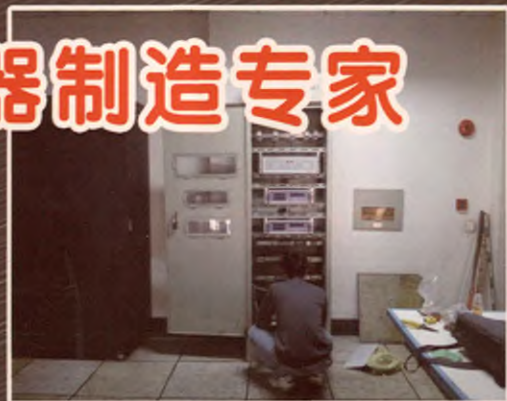
我公司工作人员在八钢中板厂仪表调试现场
