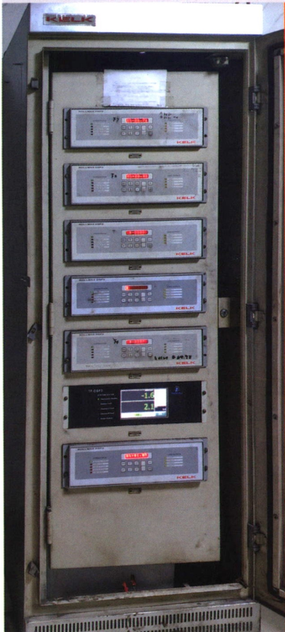
日照钢铁TF-DSP3控制安装现场
