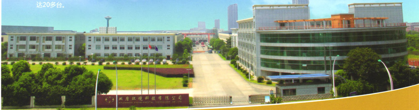
国电泰州发电有限公司一期工程 2×1000MW机组湿式电除尘器
