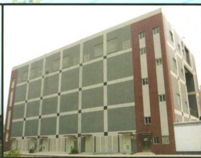
110kV利海变电站工程
