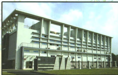
万方数据 110kV平西变电站工程
