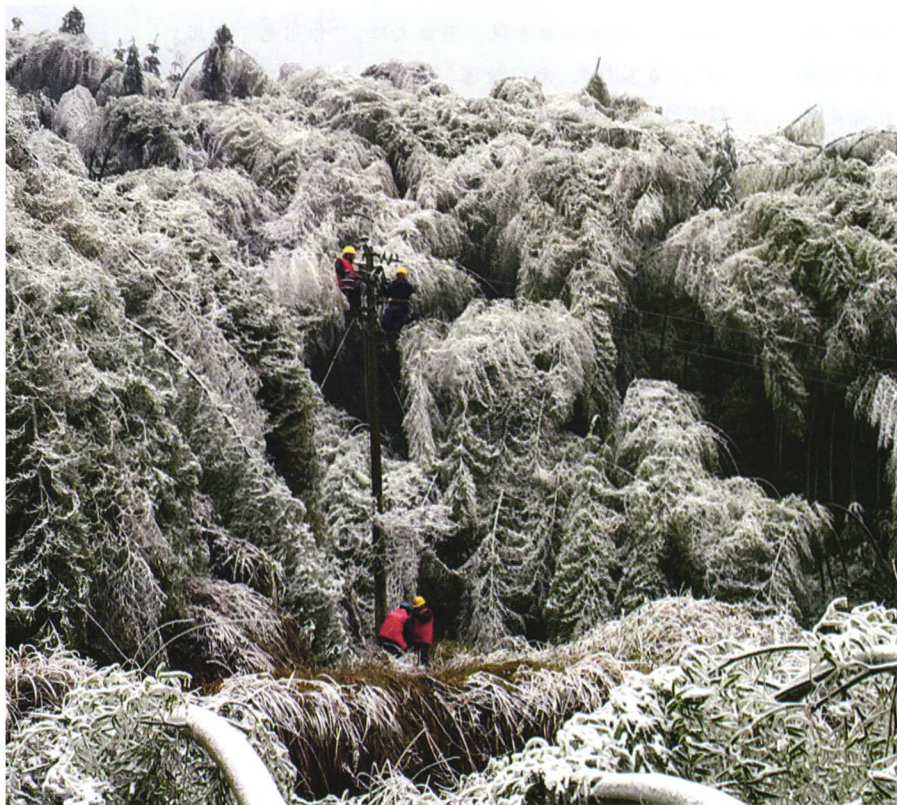
1月29日，雨雪冰冻天气造成江西省铅山县10千伏石英线断线，导致大横村、小横村12个台区650余户居民停电。图为国网江西省电力有限公司铅山县供电公司党员服务队冒雪抢修线路的工作场景 叶盼 摄
