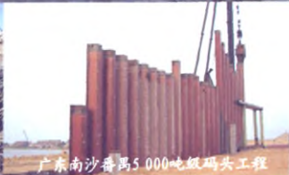
广东南沙番禺5000吨级码头工程
