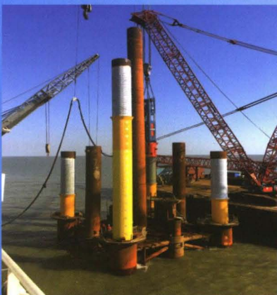
大丰海上风电场施工 YC-80
