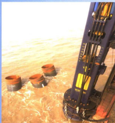
岱山跨海大桥施工 YC-50
