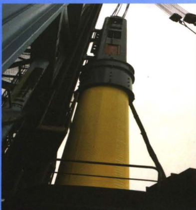
莆田南日岛中交一航局风电项目
