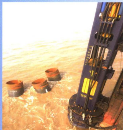
岱山跨海大桥施工 YC-50
