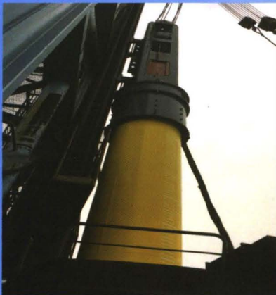
莆田南日岛中交一航局风电项目
