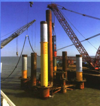
大丰海上风电场施工 YC-80
