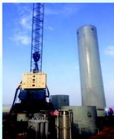
浉垣高速黄河特大桥项目
