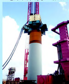
鱼山大桥项目
