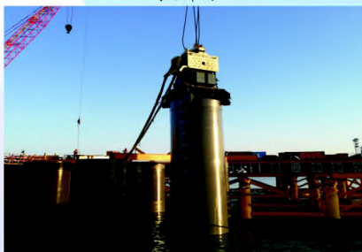
深中通道项目
