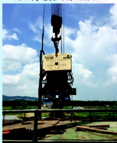
武穴市砂石集散中心码头项目
