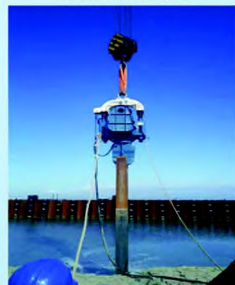
以色列阿什杜德港口码头项目
