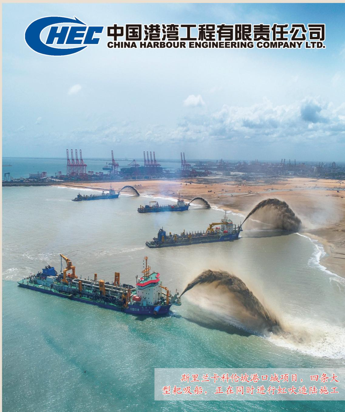
斯里兰卡科伦坡港口城项目，四条大型耙吸船，正在同时进行虹吹造陆施工
