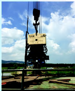
武穴市砂石集散中心码头项目
