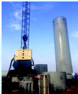
涇县高速黄河特大桥项目
