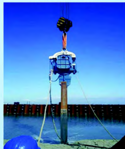
以色列阿什杜德港口码头项目
