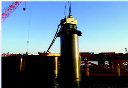
深中通道项目
