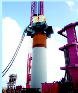
鱼山大桥项目
