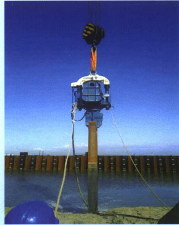
以色列阿什杜德港口码头项目
