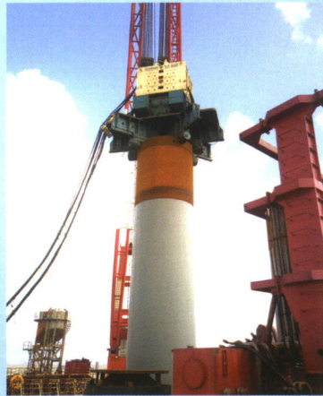
鱼山大桥项目
