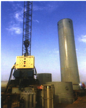
浞垣高速黄河特大桥项目
