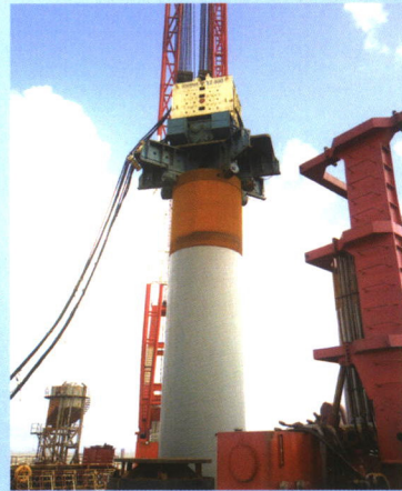
鱼山大桥项目
