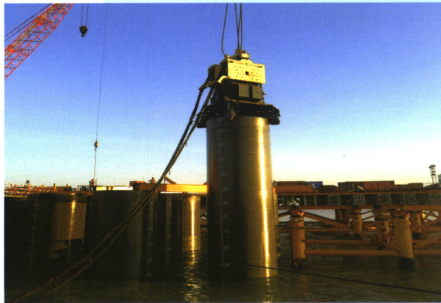
深中通道项目
