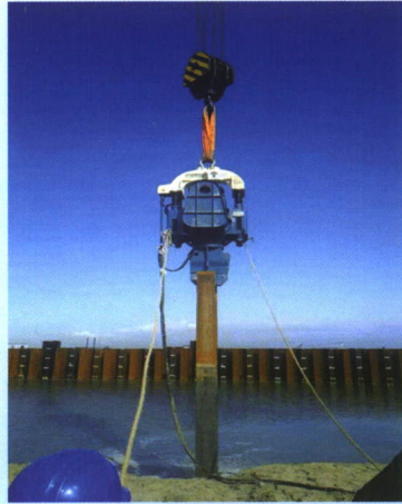
以色列阿什杜德港口码头项目
