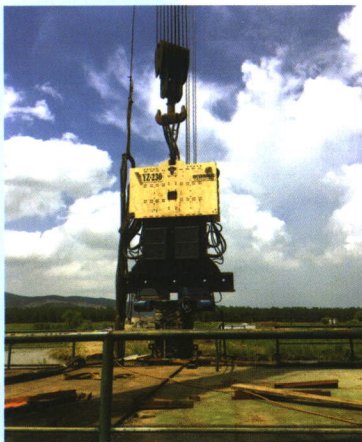
武穴市砂石集散中心码头项目
