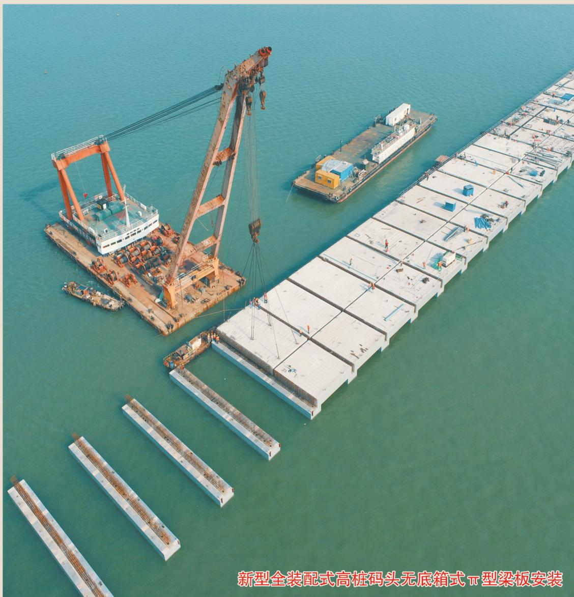
新型全装配式高桩码头无底箱式  $\pi$  型梁板安装
