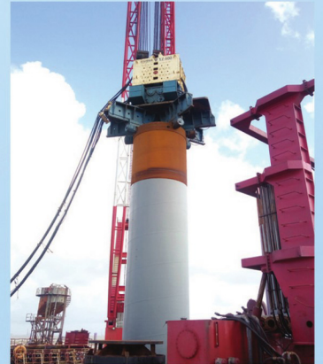
鱼山大桥项目
