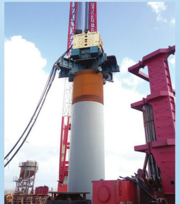
鱼山大桥项目
