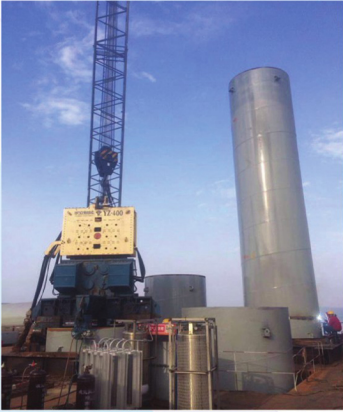
涇垣高速黄河特大桥项目
