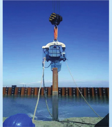
以色列阿什杜德港口码头项目
