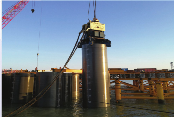
深中通道项目
