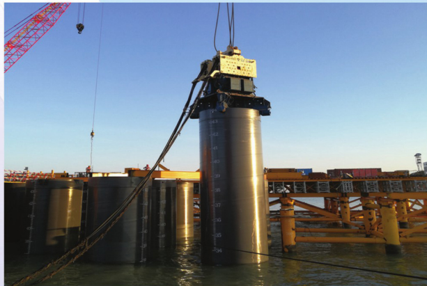
深中通道项目
