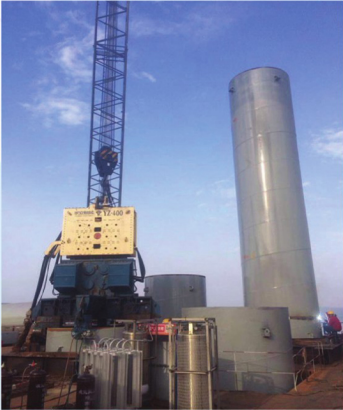
涇垣高速黄河特大桥项目
