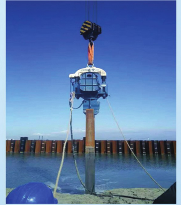
以色列阿什杜德港口码头项目
