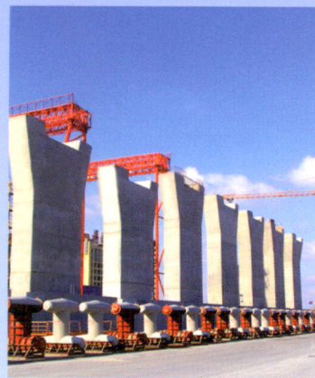
港珠澳大桥墩台预制
