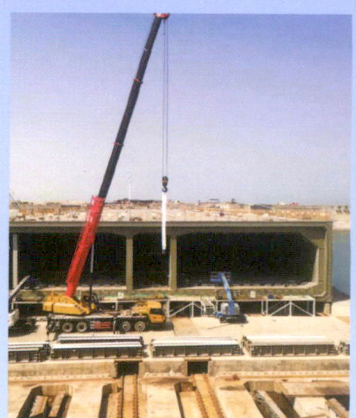
深中通道沉管舾装
