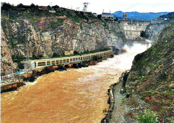
刘家峡水电站
