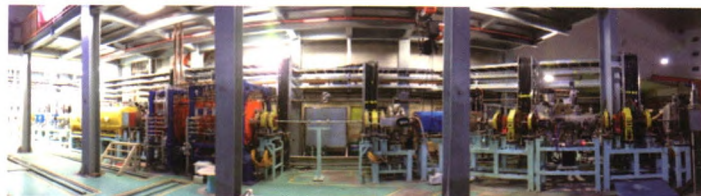
▲ SSC-Linac直线注入器
