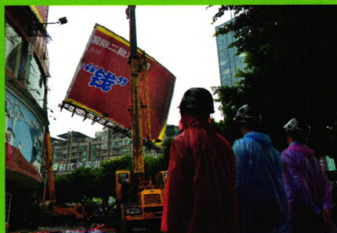
执法人员冒雨 拆除位于新欧乡楼顶的大型户外广告牌
