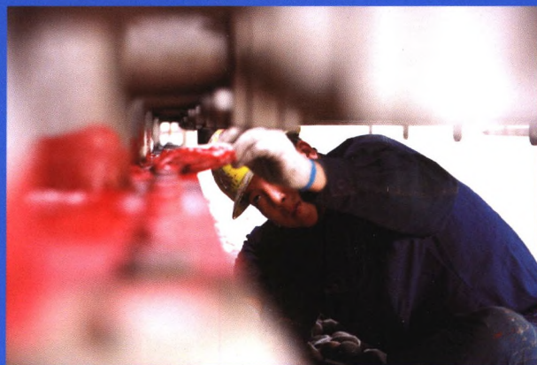
员工在110千伏黄土埂变电站狭窄的空间内为主变压器刷涂防锈漆
